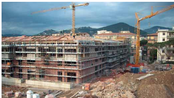
Panoramica delle lavorazioni in corso in un cantiere di edilizia residenziale: posa in opera dei blocchi in un solaio di copertura e del rivestimento esterno in laterizio faccia a vista.
