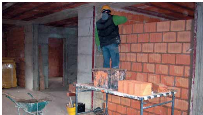
Posa in opera di elementi in laterizio per strutture di partizione interna con l'ausilio di ponti su cavalletti.
