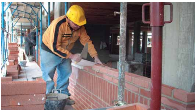
Posa in opera di un paramento murario in "tozzetti" di laterizio faccia a vista.
