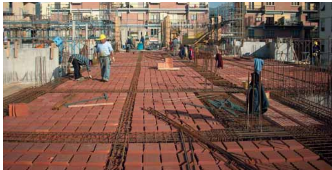
Una volta posato in opera, il solaio diventa un luogo dove lavorare in sicurezza: nell'immagine, disposizione dell'armatura metallica.
